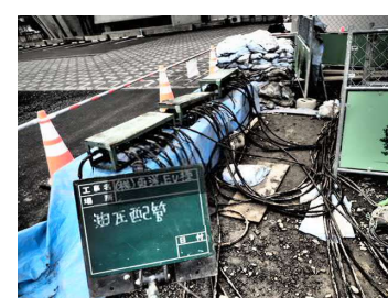
ジャッキアップ工事 油圧配管
